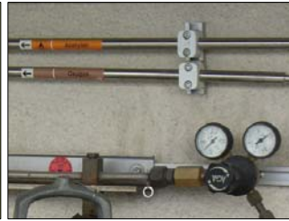
Etiketter kontrolleras för läsbarhet. De görs rent från smuts eller fett, eller byts ut.
